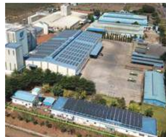
DE HEUS 963,37 kWp
