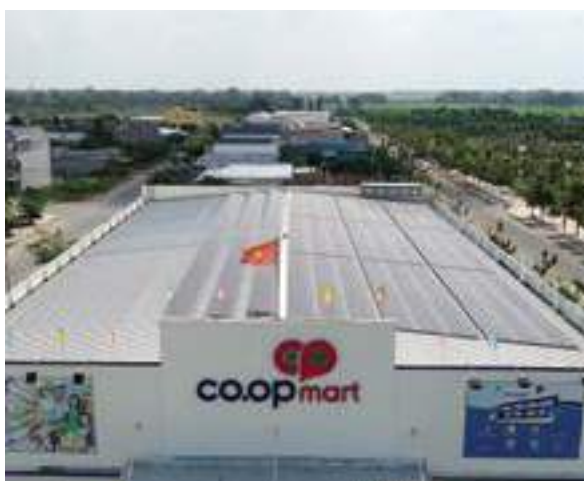
CO.OPMART HỒNG NGỰ 257,07 kWp
