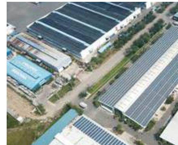
KCN KIZUNA 2 999,24 kWp
